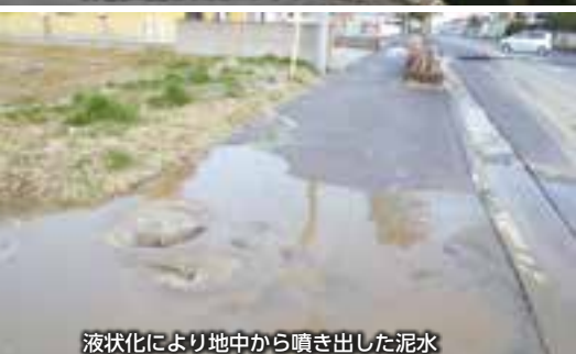
液状化により地中から噴き出した泥水
