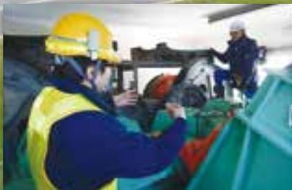
塔の上部はゲート巻き上げ機室。巨大な歯車でゲートを持ち上げる
