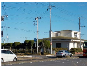
港南中継ポンプ場
