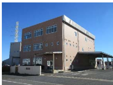
第一リサイクルプラザ
