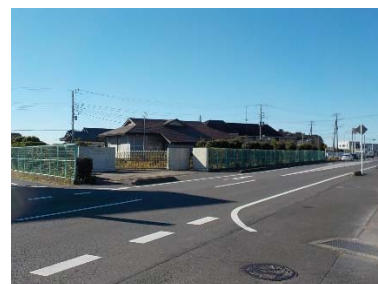
柳堀中継ポンプ場
