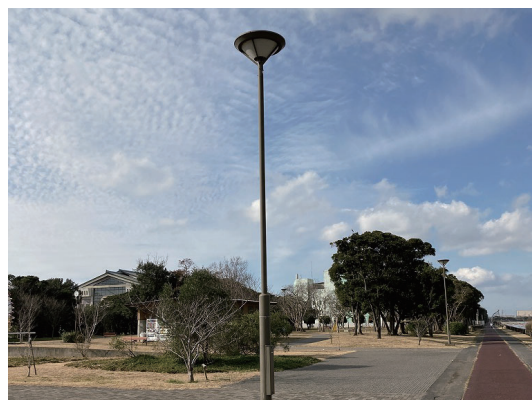
現況の公園灯(LED化未整備)
