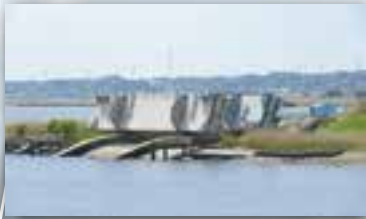
ゲートを工事するとき使用する予備ゲート
