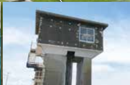
塔の上部はゲート巻き上げ機室。巨大な歯車でゲートを持ち上げる
