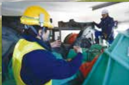
塔の上部はゲート巻き上げ機室。巨大な歯車でゲートを持ち上げる
