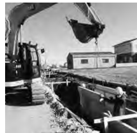
雨水排水対策工事
