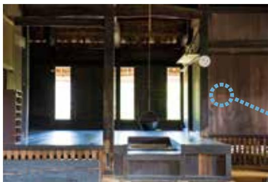
東日本大震災時の津波による浸水の高さを示す。壁にうっすらと水の跡が残っている。土壁は削られ建具は流されたが建物は耐え残った。
