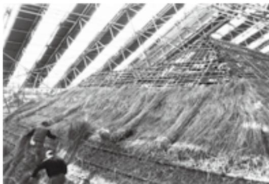
復元される茅葺屋根。葦の長さをそろえて束ねる、屋根に敷き並べる、刈り込むなど多くの工程を経て仕上げる(上・左)。
