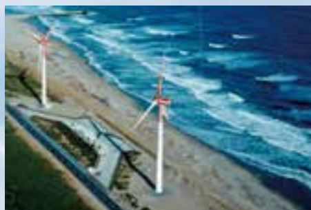
エコ・パワー(株)が設置した波崎風力発電所
