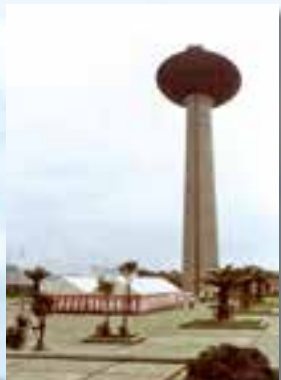
竣工当時の展望塔(昭和55年)
