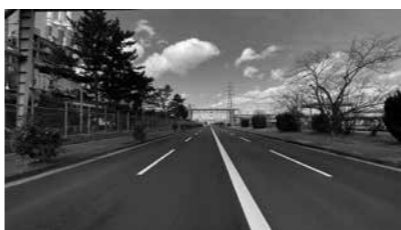
整備された市道8-101号線(東和田地内)
