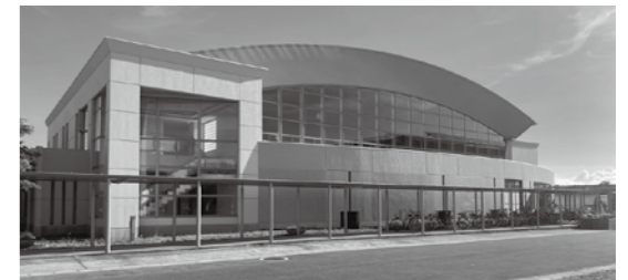
神栖第三中学校体育館
