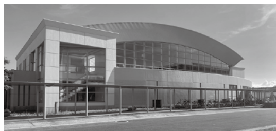
神栖第三中学校体育館
