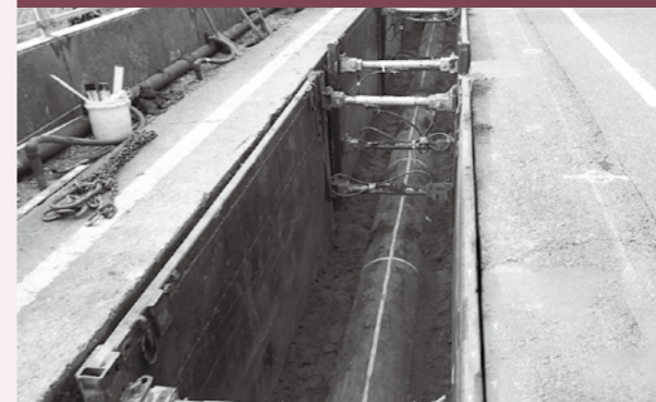
2022年度 圧送管布設工事
