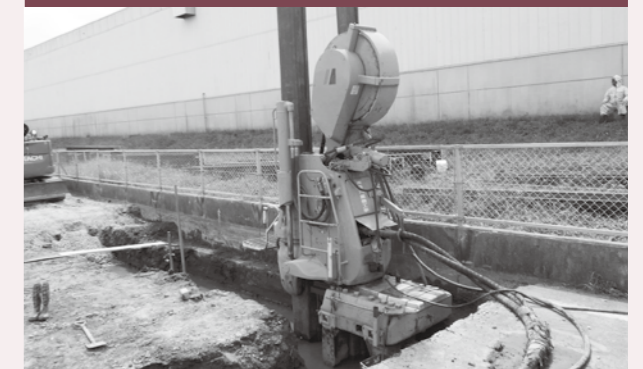
2023年度 貯留槽設置工事
