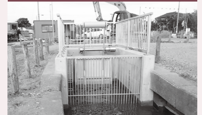
2021年度 排水路ゲート設置工事
