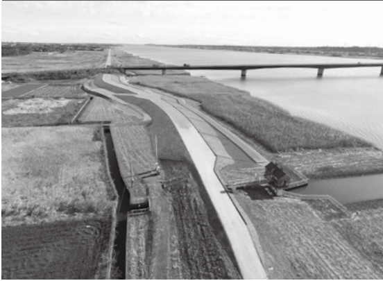
この箇所は、堤防用地の幅が確保できるため、盛り土をした土堤が整備されています。
