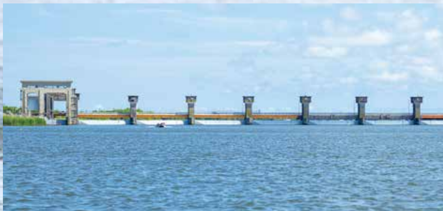
常陸利根川と逆水門
