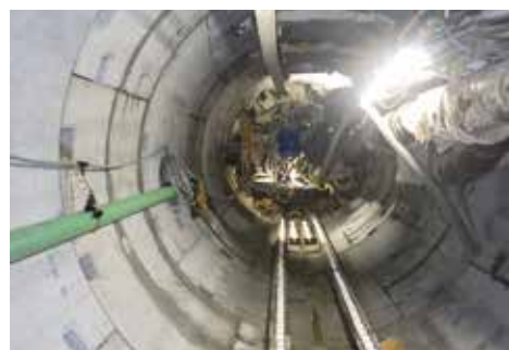
深さ9メートルの地下に造られたトンネル
