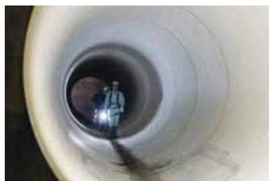
完成した巨大雨水管
