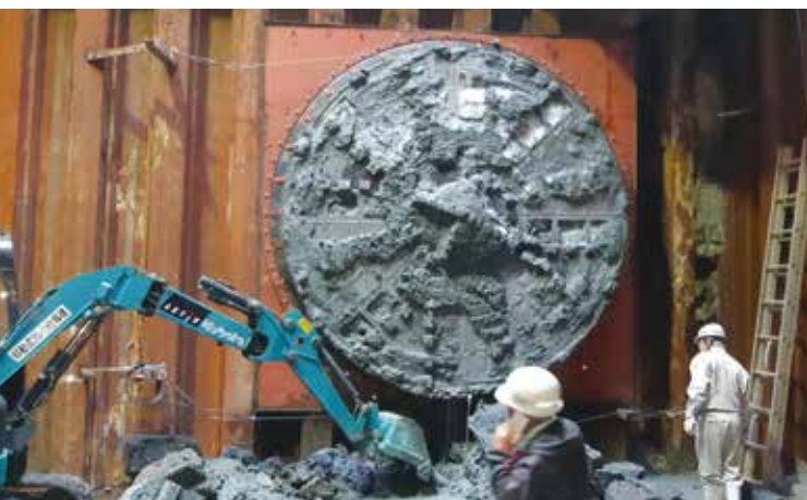
目標の到達地点まで掘り進み、泥だらけになって姿を現した推進機(写真中央)
