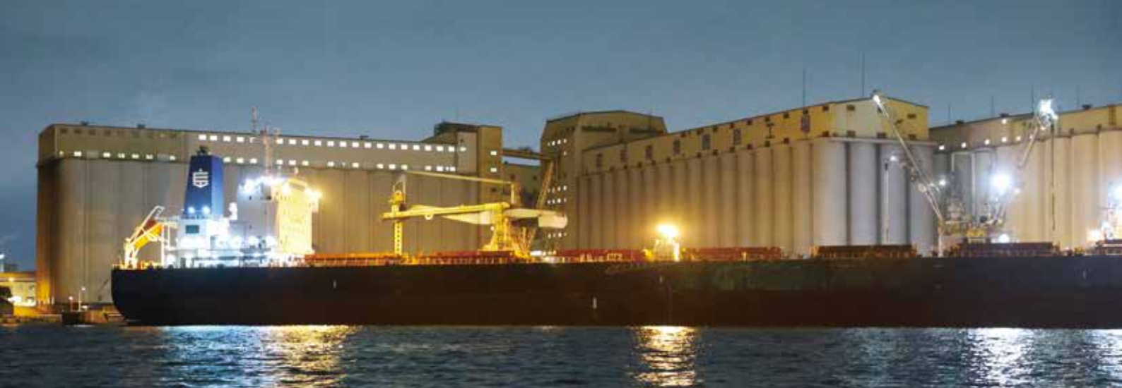
神殿のようにそびえ立つ穀物サイロ。飼料コンビナートは日本の食を支えている
