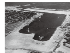
鹿島港中央航路の掘削(1967年)
