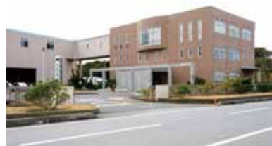
神栖市第一リサイクルプラザ
