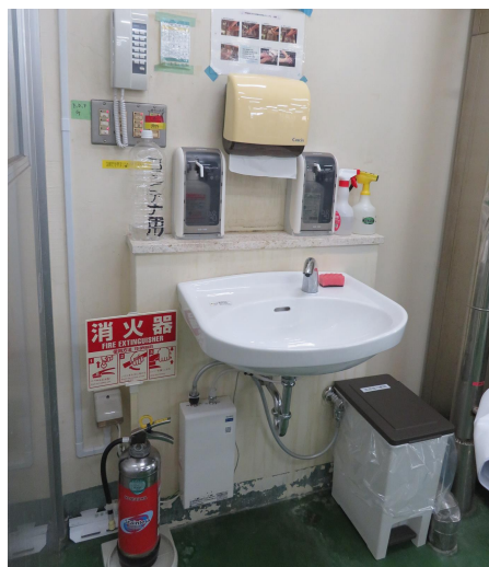
[写真4] 調理場内の手洗い場
