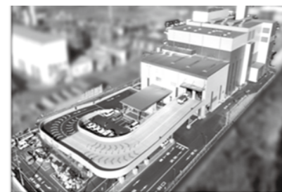
鹿島共同可燃ごみクリーンセンター
