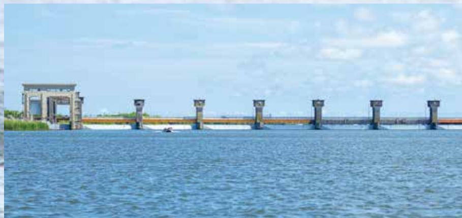
常陸利根川と逆水門
