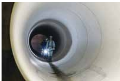
完成した巨大雨水管
