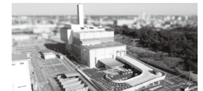
鹿島共同可燃ごみクリーンセンター
