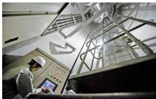
風車のタワー内部
