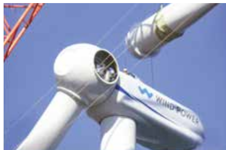
ブレード(風車の羽)の組み立て作業
