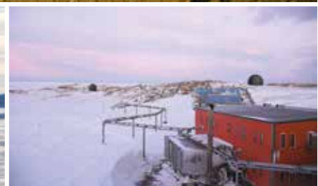
観測にかかわる施設だけでなく発電施設などもある
