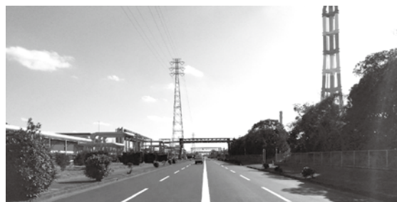
整備された市道8-101号線(東和田地内)
