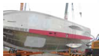
クレーンで船体を反転し船底を下にする
