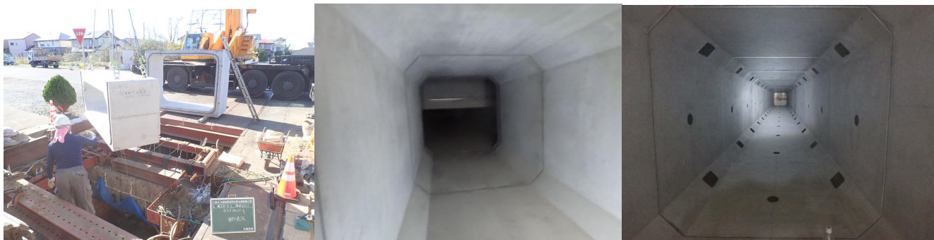
整備後 1. 4m×1.4mの排水路を市道下に整備いたしました。
