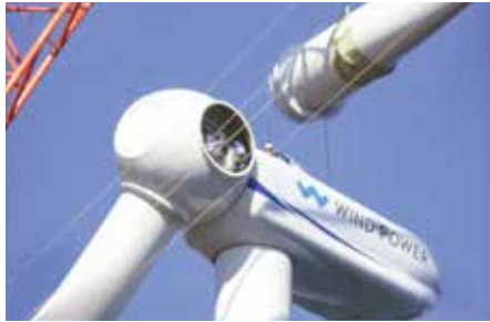
ブレード(風車の羽)の組み立て作業
