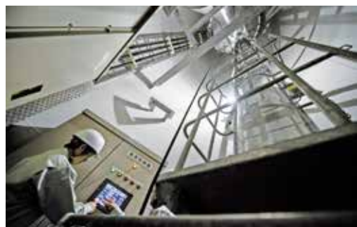
風車のタワー内部
