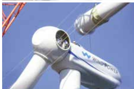
ブレード（風車の羽）の組み立て作業
