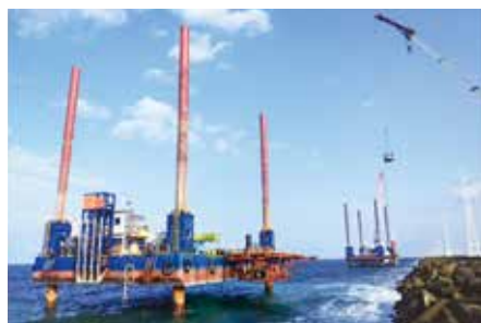
洋上での専用船による風力発電施設の施工
