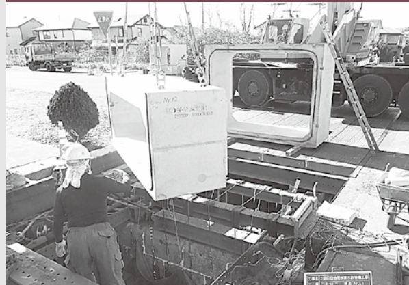
排水路整備状況
