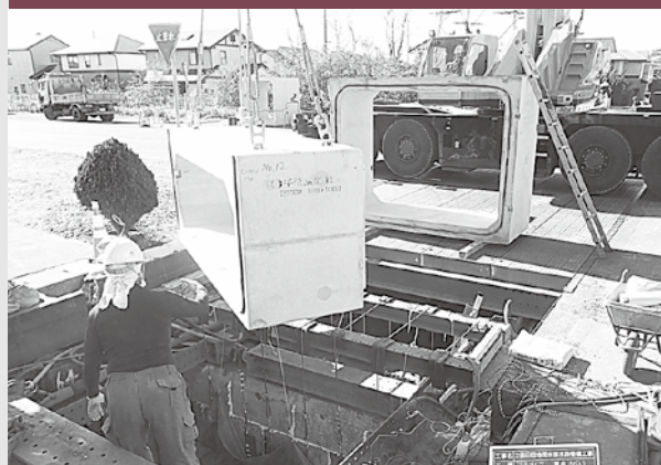
排水路整備状況
