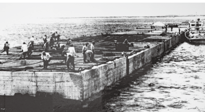
左上／鹿島港開発前の海岸線。鹿島砂丘が広がっていた※ はおおよその現在の中央航路の位置 右上／中央航路にひしめく浚渫船(昭和44年頃) 左下／防波堤ケーソン据え付けの様子。当時は人力でおこなっていた(昭和44年頃) 右下／鹿島港港口付近の造成状況(昭和45年頃)
