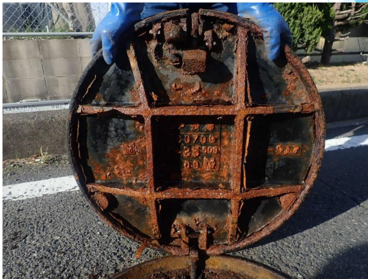
○当市でのマンホール鉄蓋点検例
