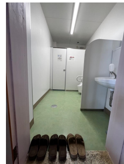
掲載場所：⑥ 体育館男子トイレ 小便器 2 箇所、大便器 1 箇所
