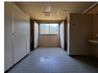
掲載場所：⑤ 1階女子トイレ 大便器3箇所
