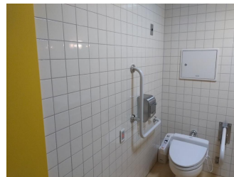
掲載場所：⑥ 2 階多目的トイレ 大便器 1 箇所
