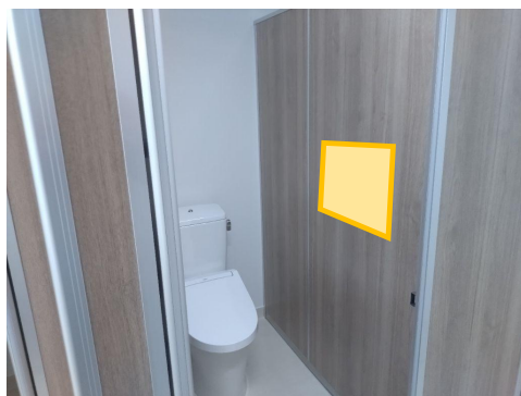
▲大便器トイレブース内（A3判） ※掲載位置はブース内の目に 付きやすい位置となります。
