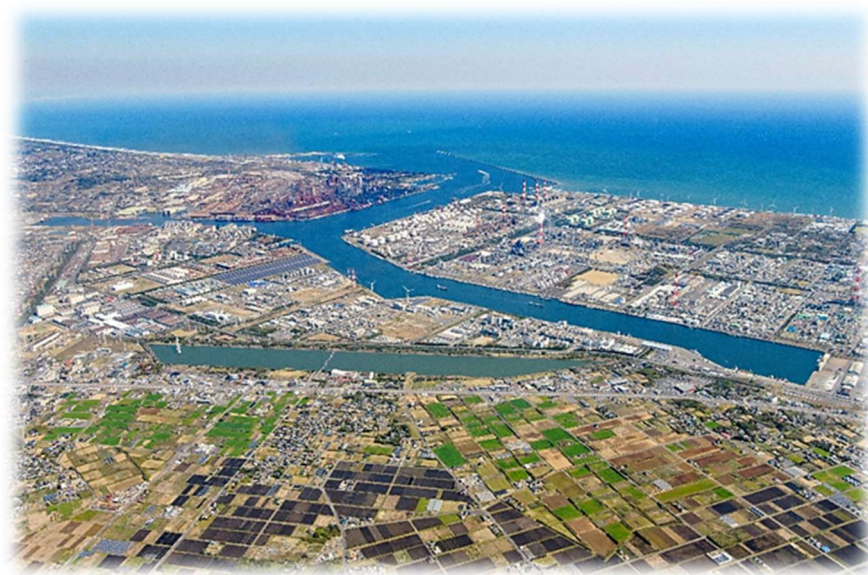
神栖地域の鹿島港と鹿島臨海工業地帯の工場群 (写真上方が太平洋、中央が神之池〈ごうのいけ〉)
